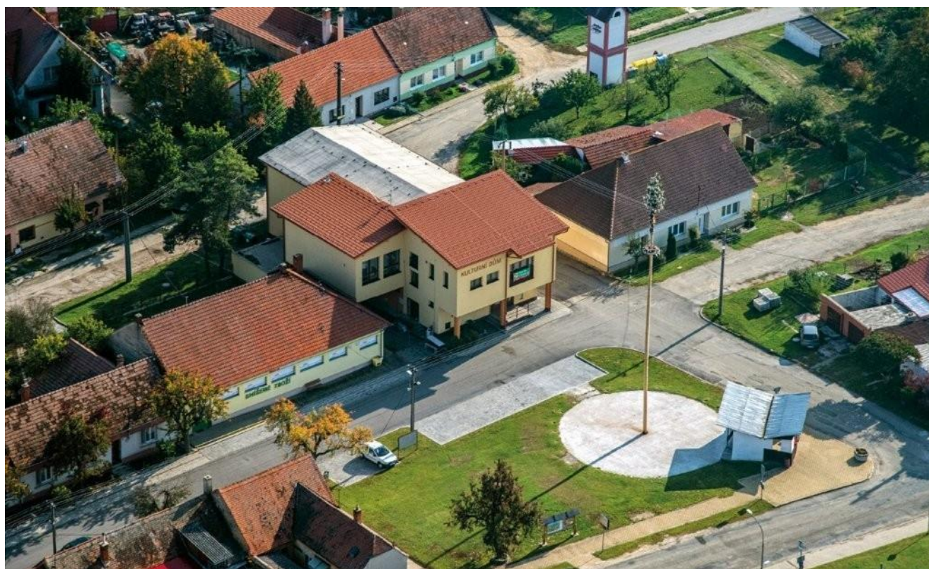
Obrázek 24: Hlavní ulice částí obce, zdroj: Obec Vedrovice
