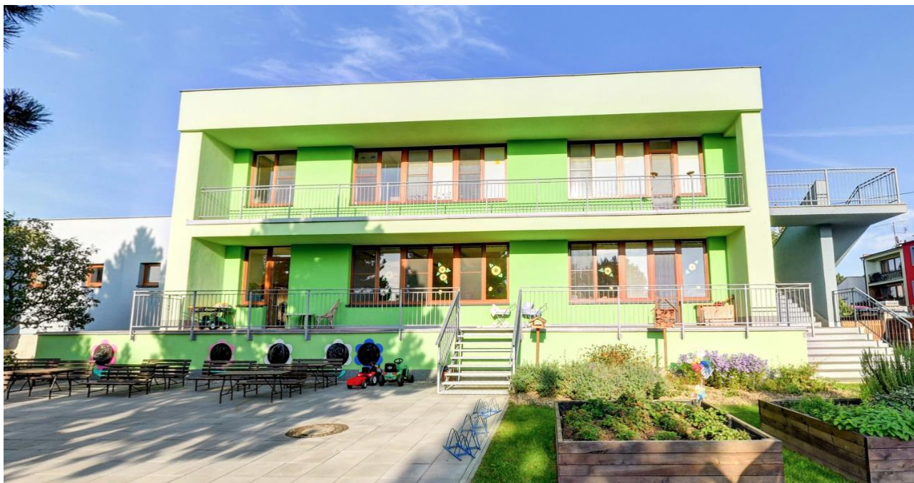
Obrázek 21: Budova mateřské školy, zdroj: webové stránky obce
